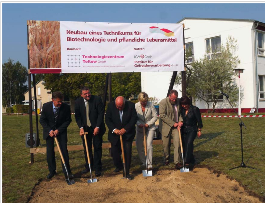
Spatenstich am 04.09.2009 zum Bau des Technikums für Biotechnologie und pflanzliche Lebensmittel mit dem Finanzminister des Landes Brandenburg Rainer Speer
